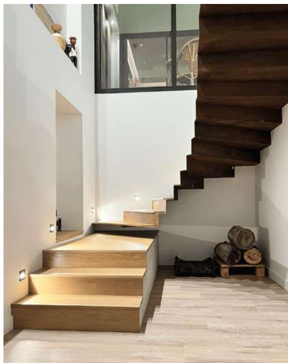
Escalier sculptural. La structure s'appréhende en deux temps, avec une première partie en béton et une seconde en métal, comme en lévitation. Les marches sont en bois pour assurer le confort à chaque pas.
