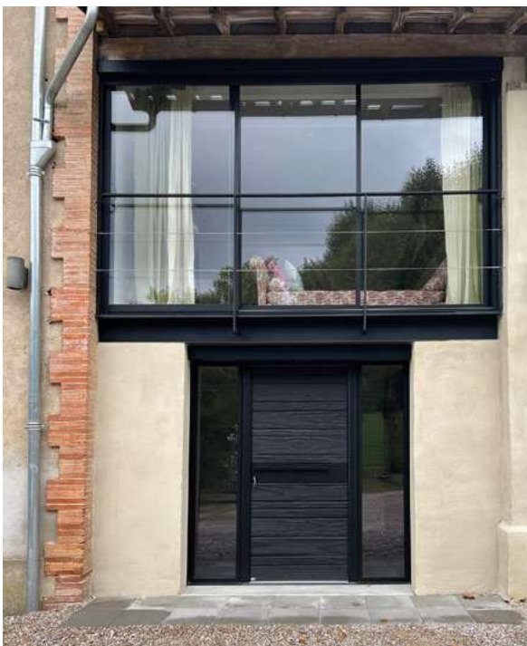
Porte d'entrée en bois brûlé. Cette méthode ancestrale japonaise permet d'obtenir une couche de carbone protectrice, entraînant une grande résistance aux intempéries et aux champignons.
