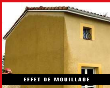
REMONTÉES D'HUMIDITÉ
