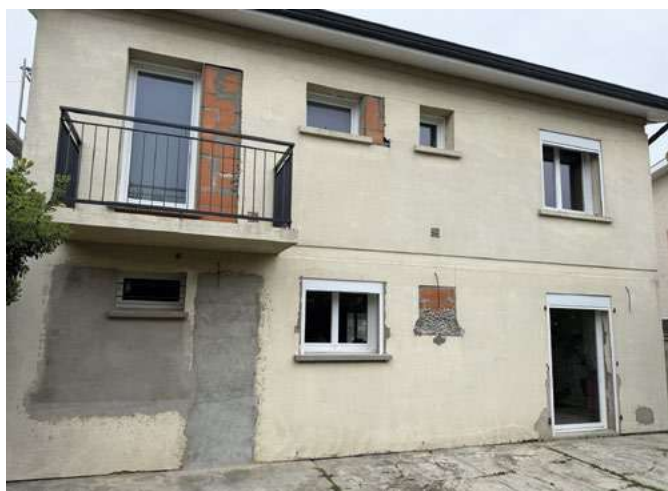
Avant travaux, la façade présente un patchwork hétéroclite de matériaux (crépis, briques, béton) dû à la suppression et la création de nouvelles ouvertures.
