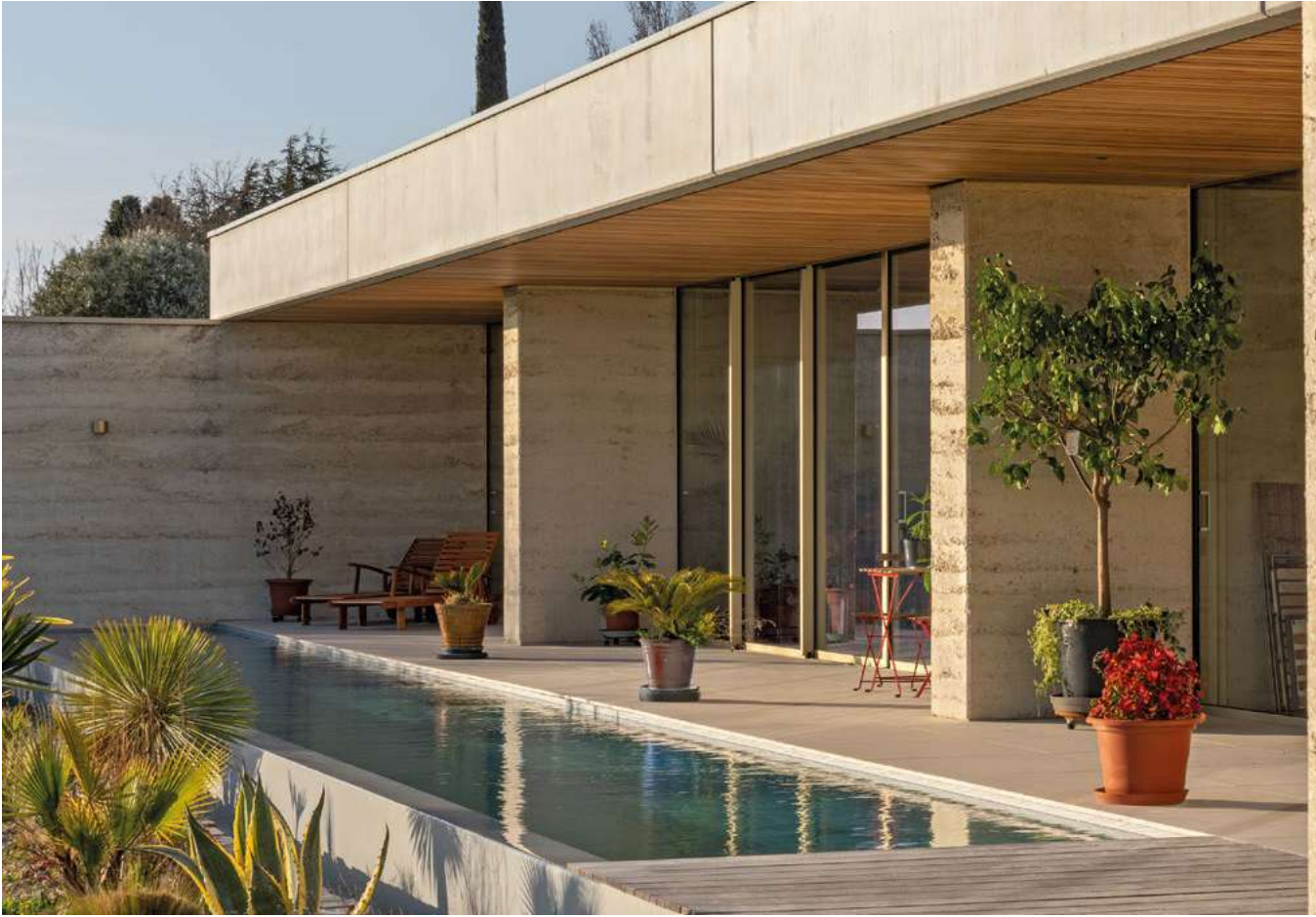
Succession de voiles pisés. Les murs ont été positionnés perpendiculairement aux vents dominants, puissants dans le Lauragais.
