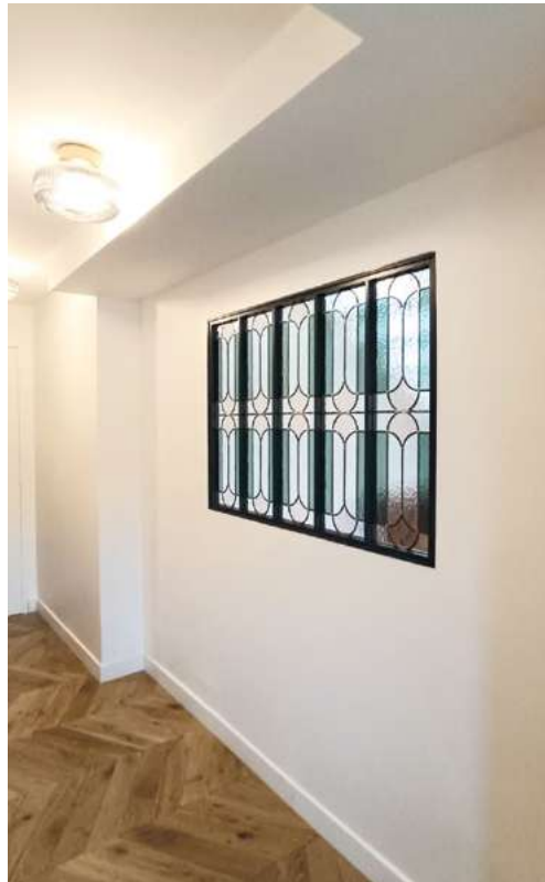
Création d'un cadre métallique et d'une vitrerie entre deux espaces pour laisser passer la lumière.
