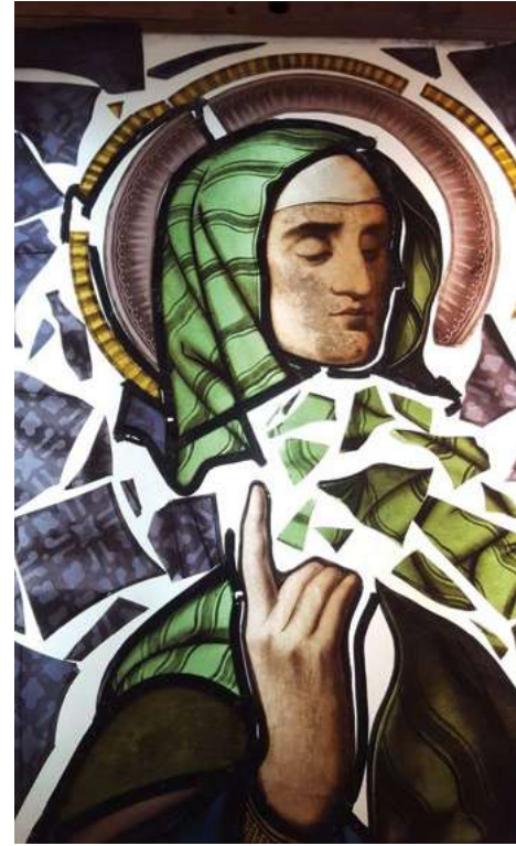
Démontage du vitrail de Sainte Anne. Rassemblement des pièces, tel un puzzle, pour remonter le vitrail et recenser les pièces manquantes à fabriquer.
