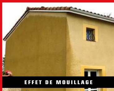
REMONTÉES D'HUMIDITÉ
