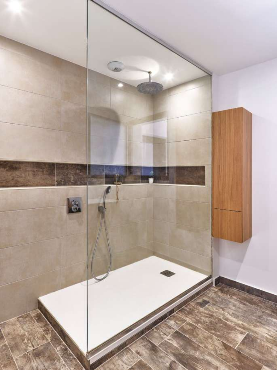
Douche rénovée. La cabine de douche, auparavant placée au centre de la pièce, a été déplacée. Une niche a été créée, avec du carrelage recyclé provenant de ce chantier.
