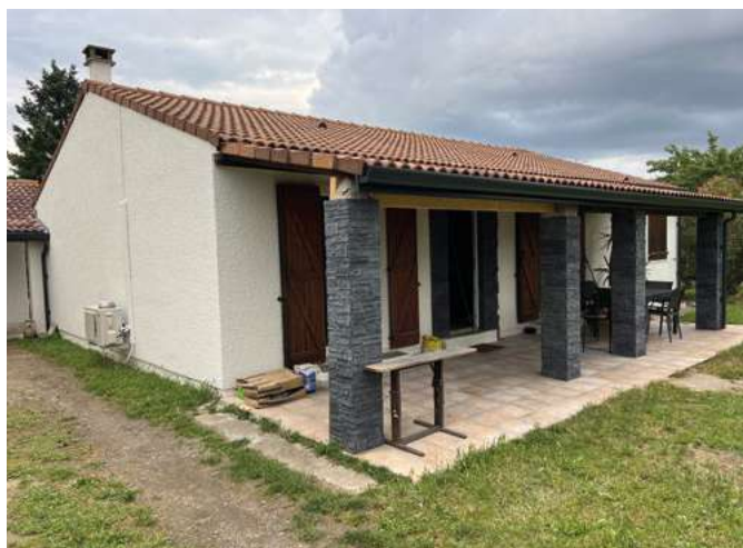
Après les travaux. Une fois la peinture isolante appliquée un gain d'énergie allant jusqu'à 8 % est constaté.
