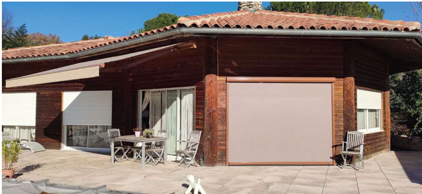
Orientation sud. Les pièces à vivre nécessitaient des protections solaires l'été. Store-banque pour l'une, store-clip pour l'autre.
